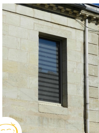
Lecture des tableaux : une position des menuiseries permettant la lecture des tableaux
