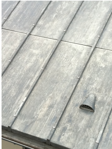
couverture à joint debout
