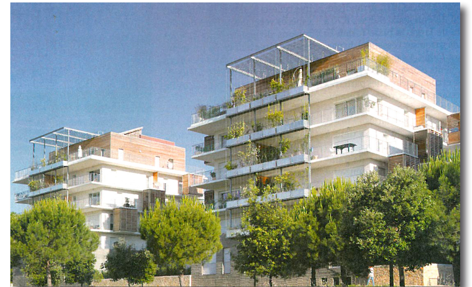
Montpellier - E. NEBOUT Architecte
