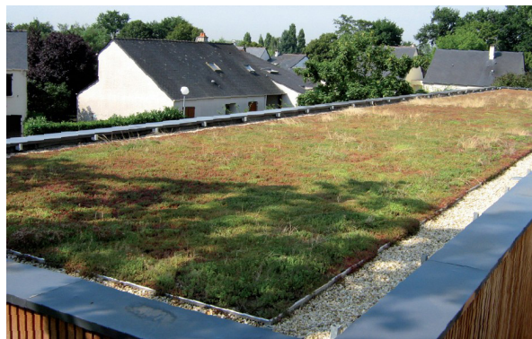
toiture terrasse végétalisée
