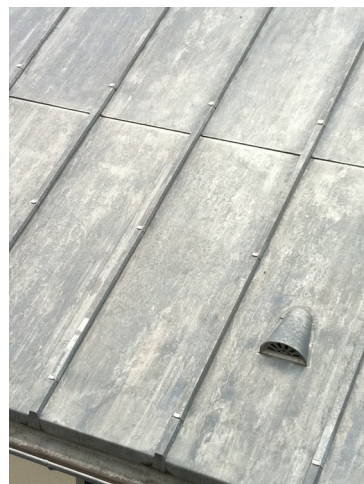
couverture à joint debout
