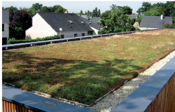
toiture terrasse végétalisée
