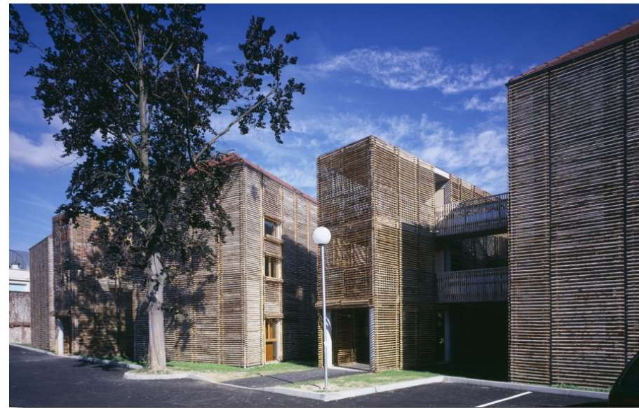
Louvier - Edouard FRANCOIS Architecte
